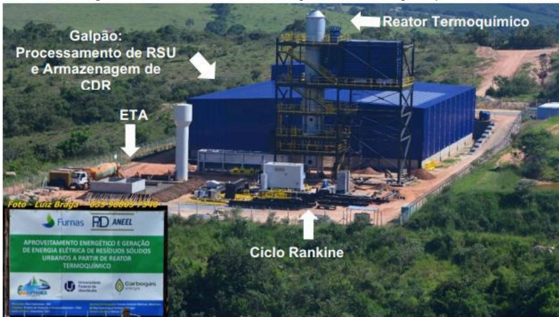
Figura 9. Vista aérea da Usina Termoquímica de Boa Esperança – MG
