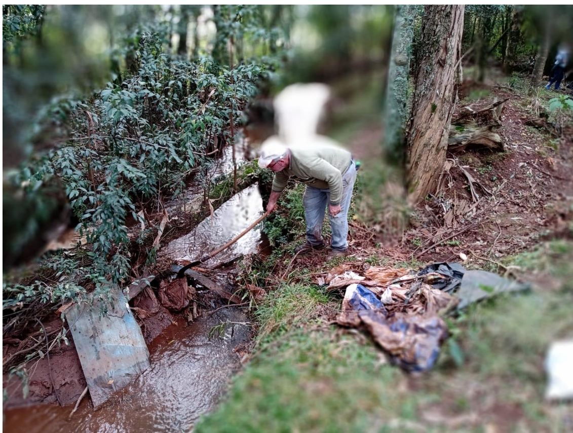
Figura 55. Retirada de resíduos do Lajeado São José no ponto 15 - 03/07/2021
