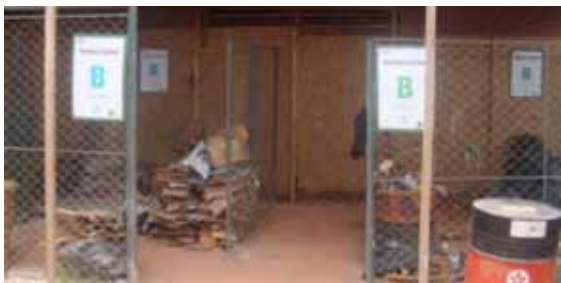
Figura 8 - Segregação de RCD no canteiro de obras. Fonte: ECOATITUDE - ações ambientais, 2011.
