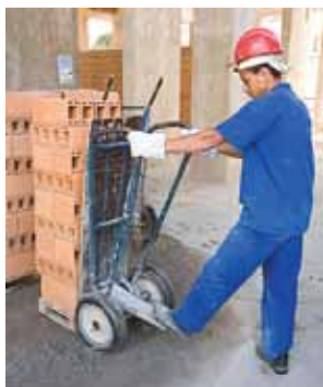
Figura 5 - Transporte adequado de blocos cerâmicos.
