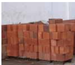
Figura 4 - Estocagem de material – paletização.
