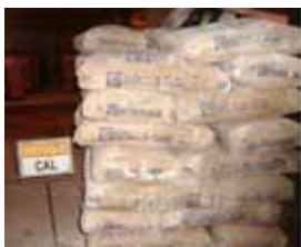
Figura 4 - Estocagem de material – paletização.
