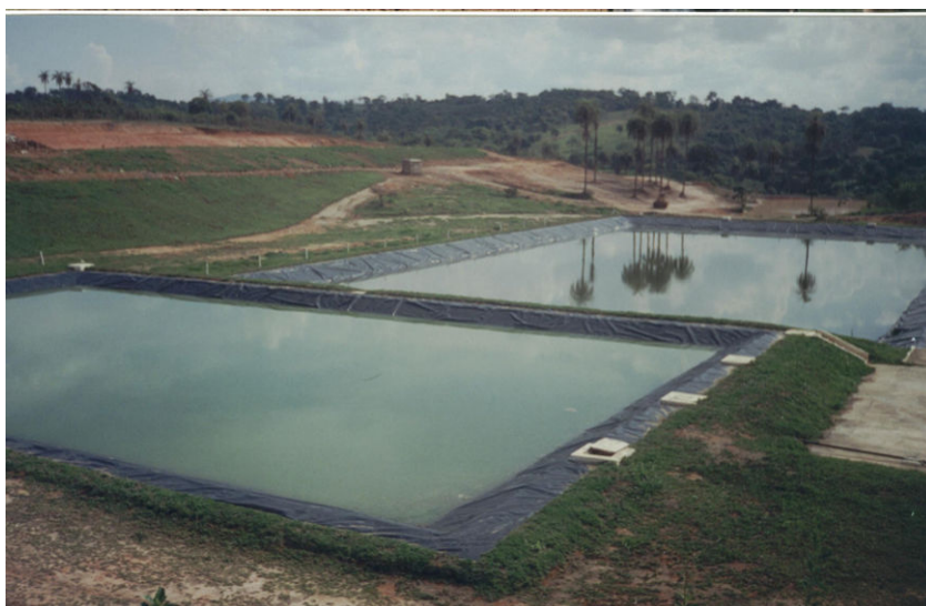
Figura 18 - Sistema de tratamento de líquidos do atual aterro sanitário do Município de Betim
