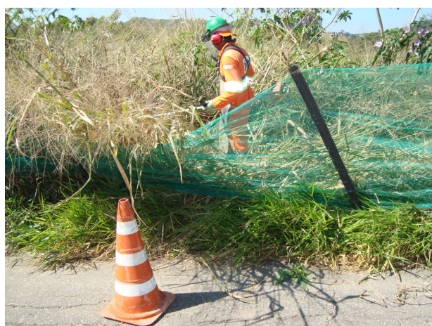
Fonte: Viasolo Engenharia Ambiental S/A Figura 15 - Roçada mecânica no Município de Betim
